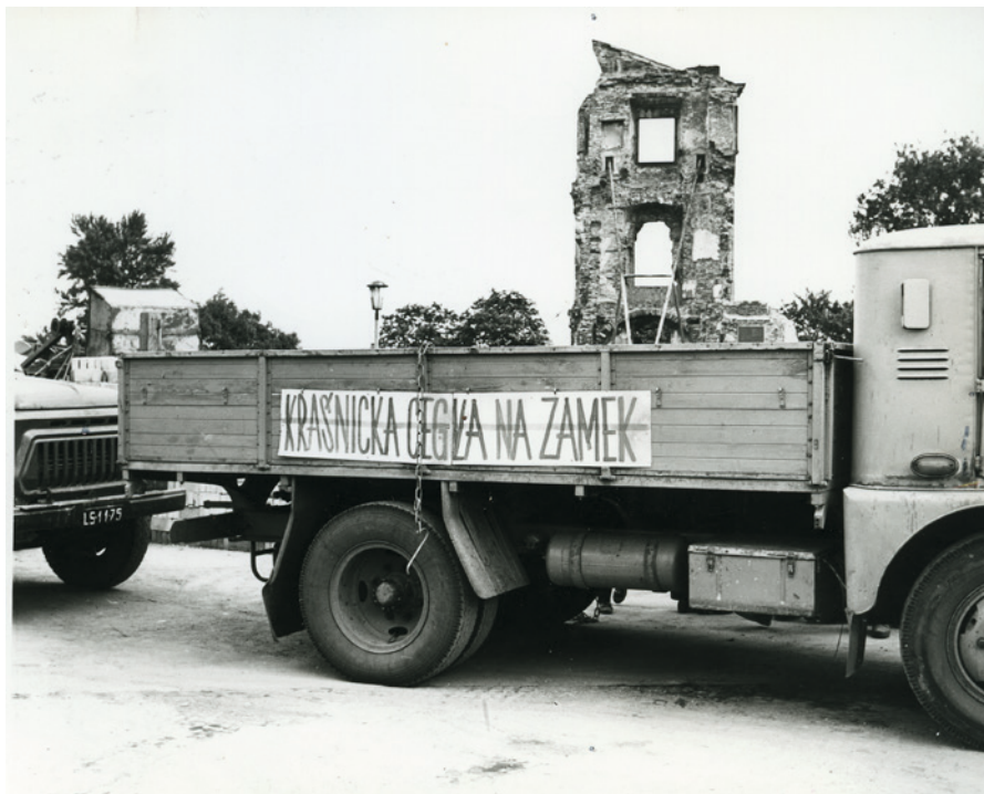
2. Transport cegły z Kraśnika wykonanej w ramach czynu społecznego przy odbudowie Zamku Królewskiego, wrzesień 1971. Fot. PAP / M. Szyperko / Transport of bricks from Kraśnik made as part of community service to rebuild the Royal Castle, September 1971. Photo PAP / M. Szyperko
